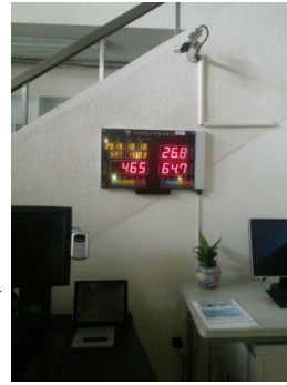
僅一樓設置 CO 2 空氣品質 監測器
