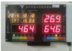
一樓及地下室 CO 2 空氣品質監測器 觸發啟動抽風扇
